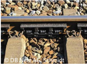
Schienenstegdämpfer
