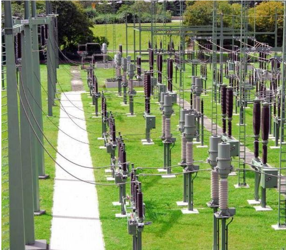
Umformerwerk 110kV Schaltanlage
