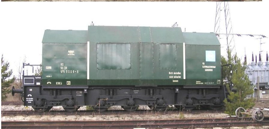
Fahrbare Sy-Sy-Umformer dezentraler Umformerwerke
